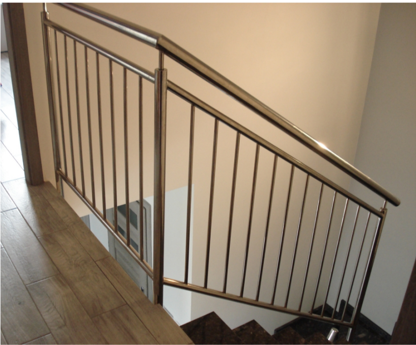
PRZYKŁADOWA BALUSTRADA - DO UZGODNIENIA NA ETAPIE WYKONAWCZYM. - BALUSTRADY POWINNY MIEĆ ROZWIĄZANIA UNIEMOŻLIWIĄCE WSPINANIE SIĘ NA NIE ORAZ ZSUWANIE SIĘ PO PORĘCZY. - MAKSYMALNY PRZESWIT LUB WYMIAR OTWORU POMIĘDZY ELEMENTAMI WYPEŁNIENIA BALUSTRADY 0,12M. - MINIMALNA WYSOKOŚĆ BALUSTRADY, MIERZONA OD WIERZCHU PORĘCZY 1,1M.
